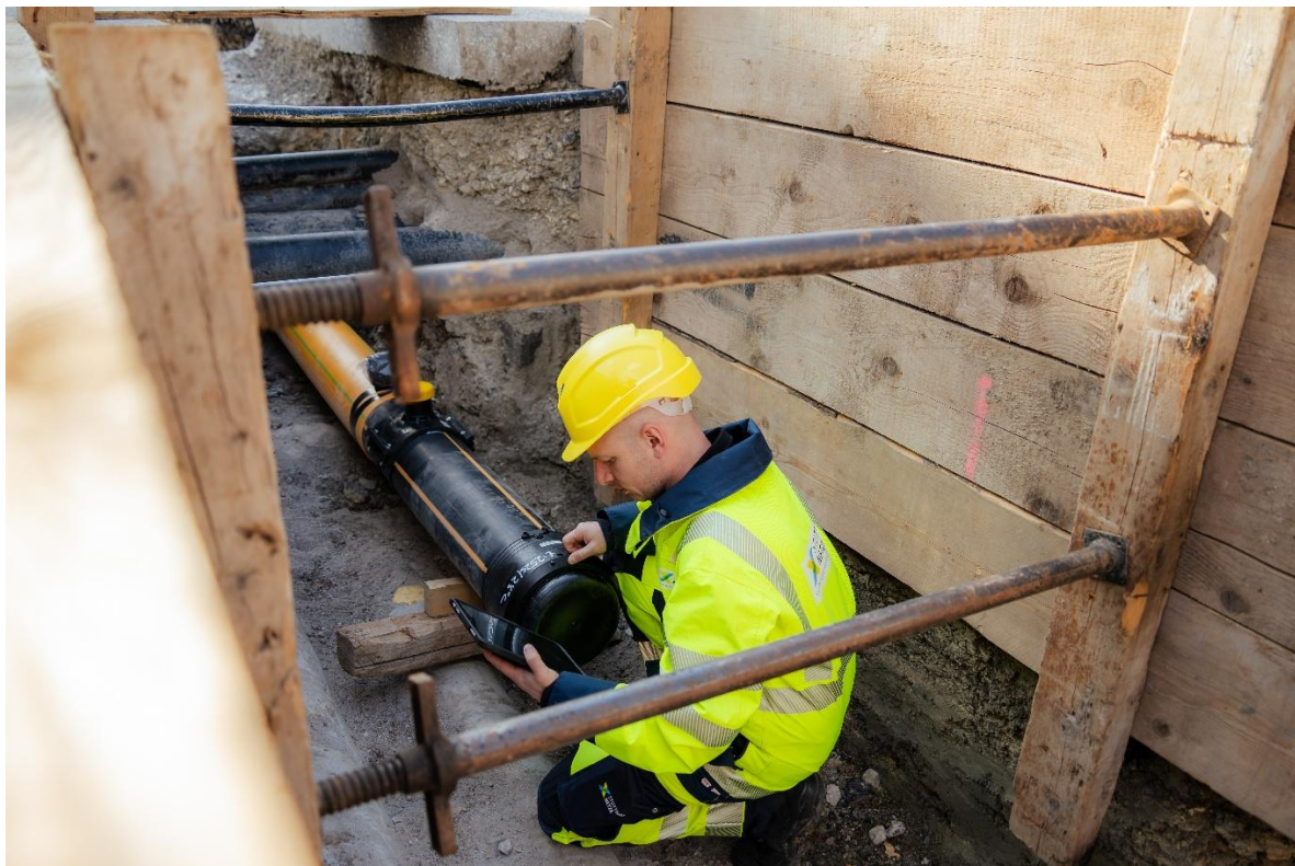
Eine Fachkraft der Stuttgart Netze bei Arbeiten an unterirdischen Versorgungsleitungen.
