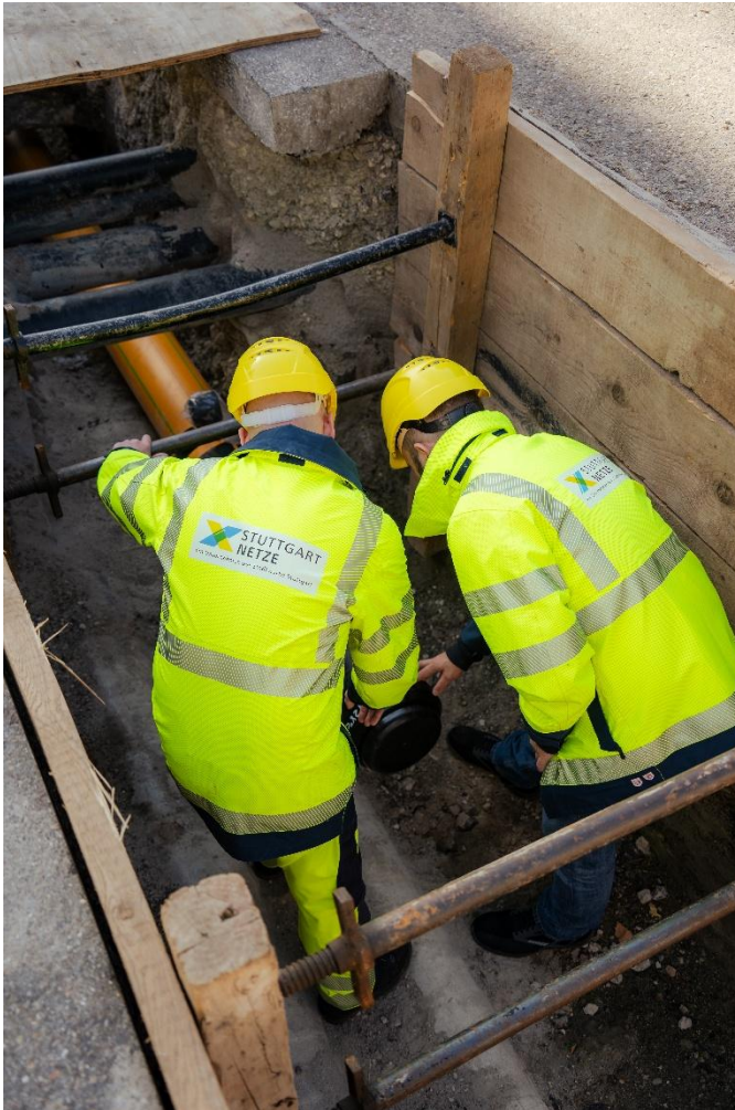
Ein Blick unter die Straßenoberfläche: Mitarbeitende der Stuttgart Netze arbeiten an unterirdischen Versorgungsleitungen.
