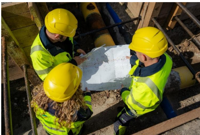
Fachkräfte der Stuttgart Netze bei Arbeiten am Gasnetz. Foto: Stuttgart Netze GmbH
