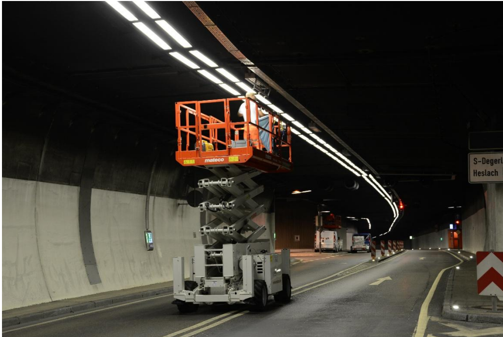
Bild: Eine Aufnahme aus dem Jahr 2018: Damals hat die Stuttgart Netze die Hauptröhren des Heslacher Tunnels auf LED umgerüstet Foto: Stuttgart Netze GmbH
