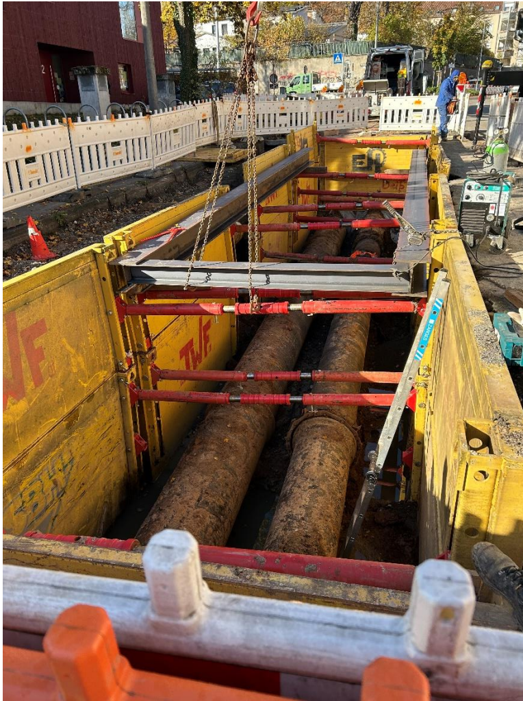
Neues Leben in alten Leitungen: In die früheren Gasrohre zieht jetzt Hochspannung ein. Foto: Stuttgart Netze GmbH
