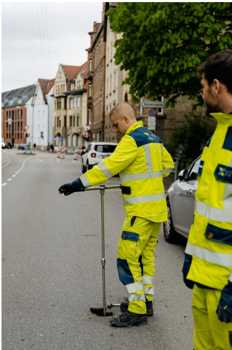
Mitarbeitende der Stuttgart Netze sperren Leitungsabschnitt für Wartungsarbeiten, Foto: Stuttgart Netze GmbH
