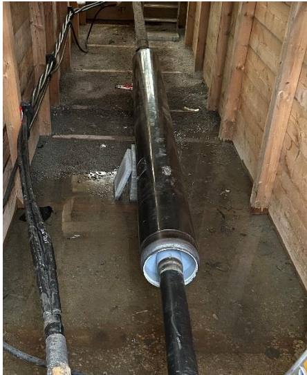
Die Stromautobahn von außen, Foto: Stuttgart Netze GmbH
