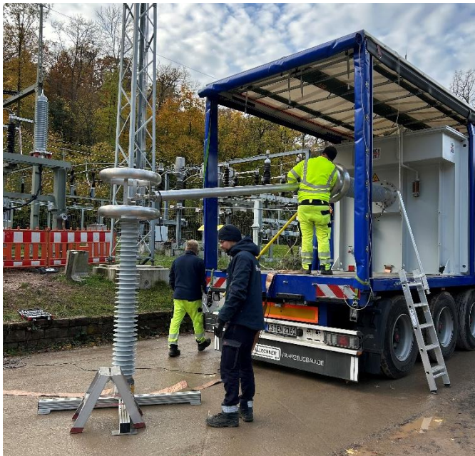
Ein Hochspannungslabor auf Räder, Foto: Stuttgart Netze GmbH
