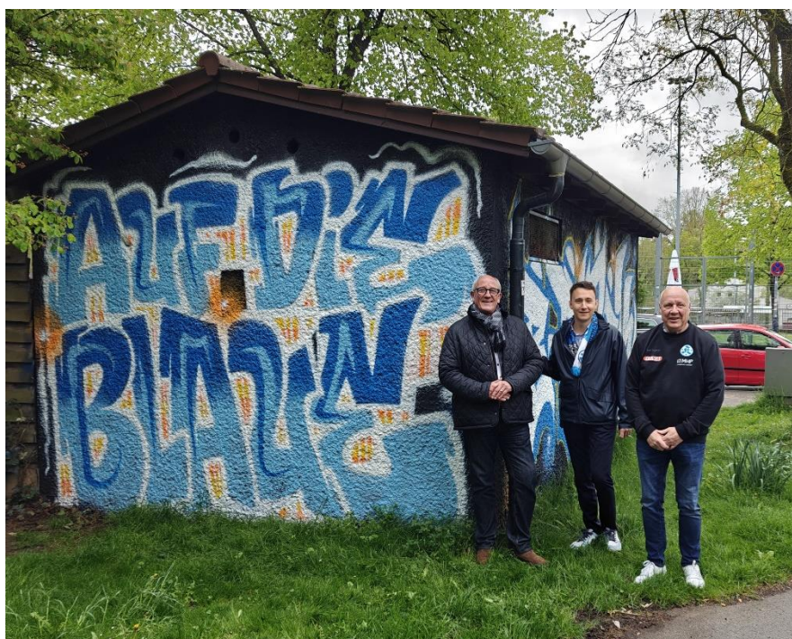
Bild: Neu gestaltete Umspannstation im Georgiiweg in S-Degerloch. Links: Harald Hauser (Technischer Geschäftsführer Stuttgart Netze), mitte: Colyn Heinze (Bezirksvorsteher S-Degerloch), rechts: Gerd Andreae (Fanbeauftragter Stuttgarter Kickers).
